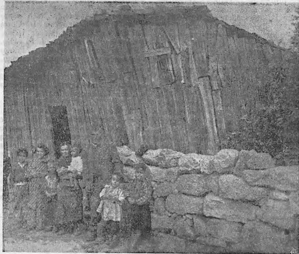
Além de ser barraca, é velha. Além de velha, é torta. Não obstante, é o abrigo de uma família de dez, segundo a notícia que temos! Está situada à beira da estrada na povoação de Santo Estevão, à saída de Chaves. Espera-se dentro em breve modificação radical. O mundo está a acordar. Levou 2000 anos a fazê-lo!
